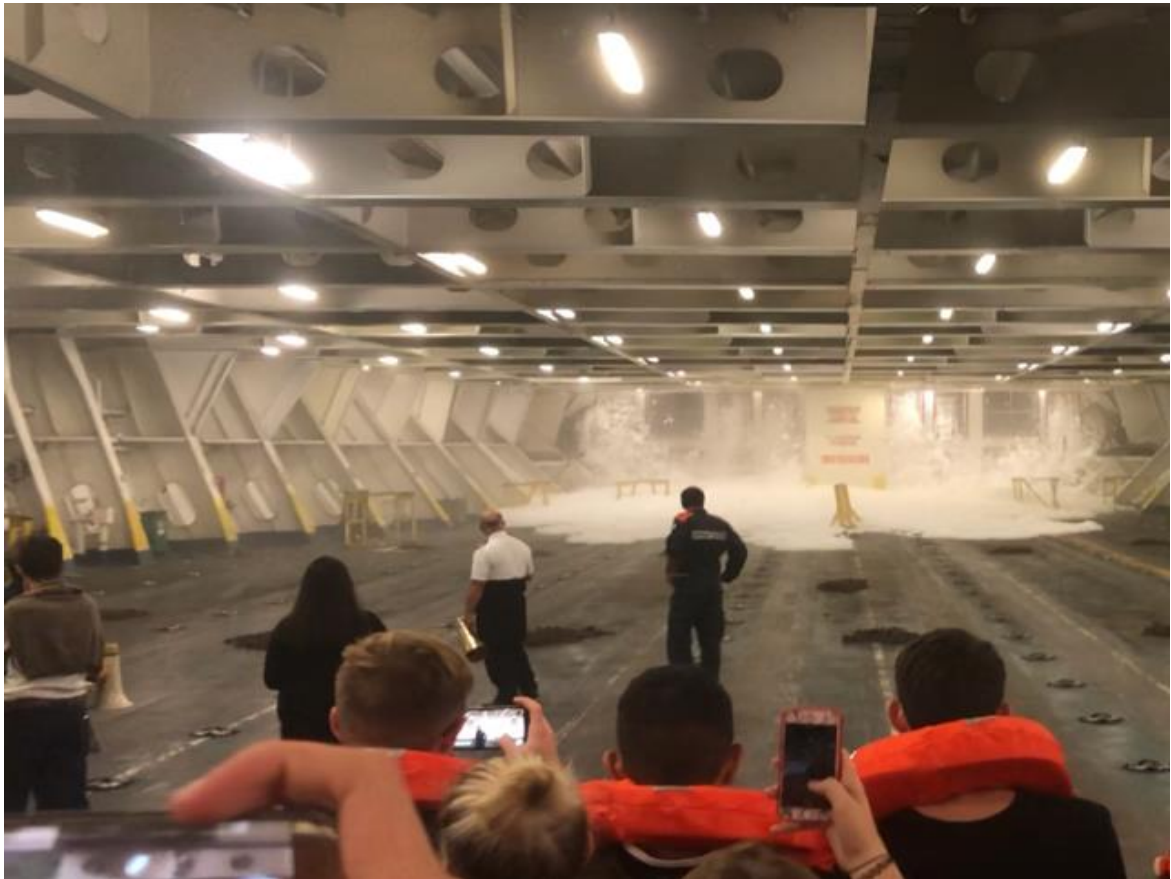
FOTO 7. Test dell'impianto di estinzione incendi a schiuma ad alta espansione 'Silvani'.
